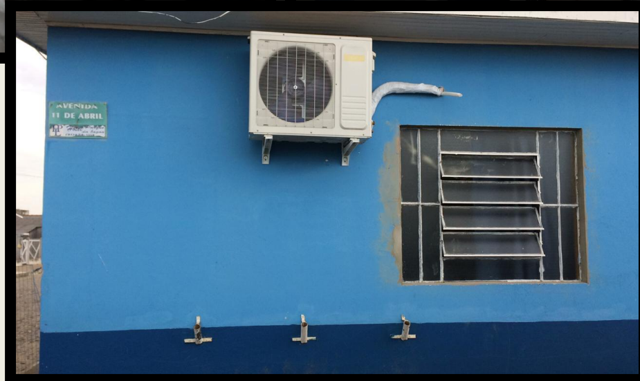
Ampliação de vagas na Pré-escola ( E.M.E.I Piazito) Construção de Sala nova (2018-2019)
