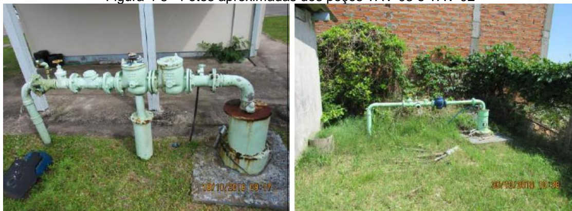
Figura 4-5 - Fotos aproximadas dos poços TAV-03 e TAV-02
