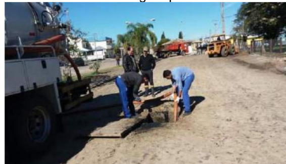
Figura 7-15 - Realização de limpeza do sistema de drenagem pluvial
