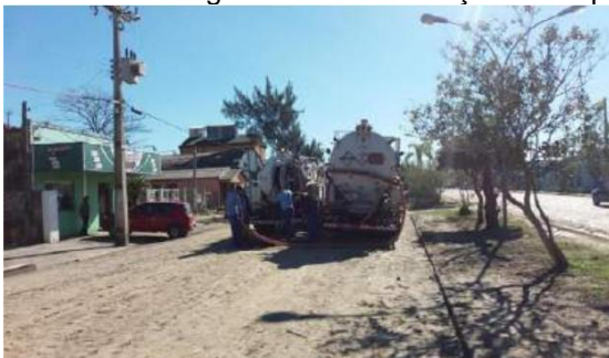
Figura 7-15 - Realização de limpeza do sistema de drenagem pluvial
