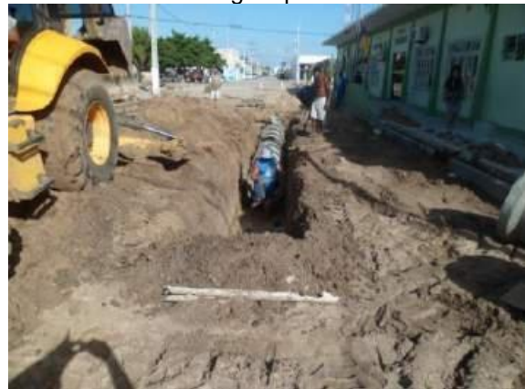
Figura 7-14 - Implantação do sistema de drenagem pluvial
