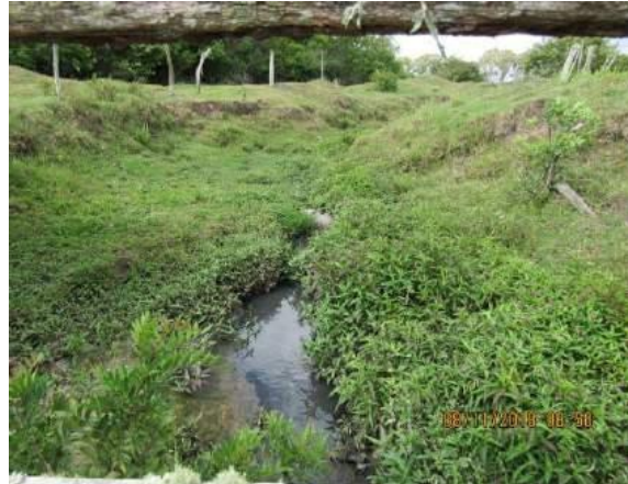
Figura 5-5 - Corpo receptor de esgotos sanitários sem tratamento
